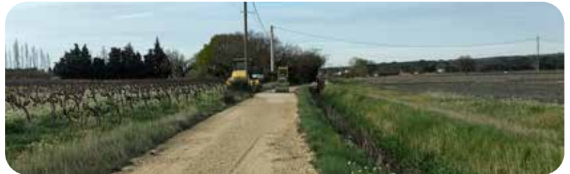
REMISE EN ÉTAT CHEMIN DE LA RABASSE
