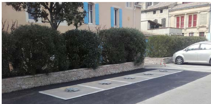
Emplacement des futures colonnes sur le parking derrière la Mairie
